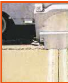
3 コア抜きにより確認された誘発。表面上では確認できない目地でもコンクリート無いでは分断されています。
